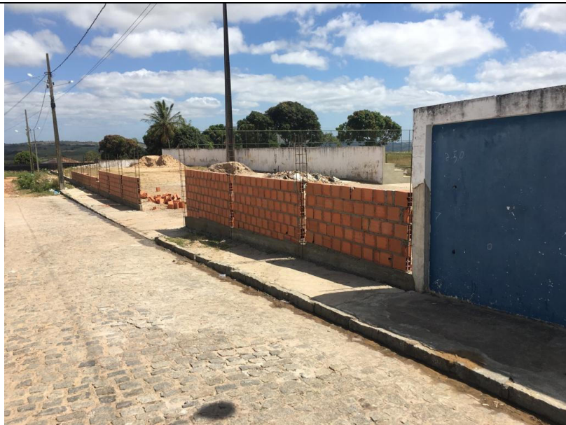
REFORMA DO ESTÁDIO FLORO ALVES DE ARAUJO
