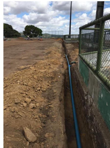
REFORMA DO ESTÁDIO FLORO ALVES DE ARAUJO
