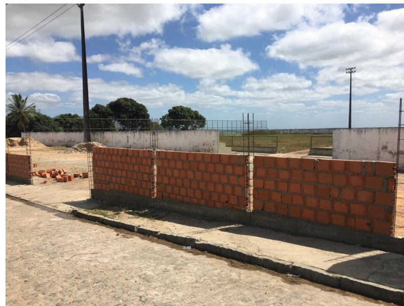
REFORMA DO ESTÁDIO FLORO ALVES DE ARAUJO
