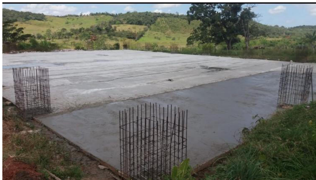
CONSTRUÇÃO DE QUADRA NO POVOADO TABUA
